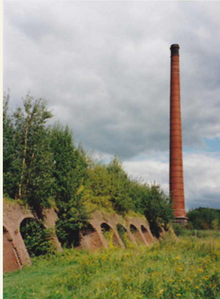
Afb. 3.41 Steenfabriek Fortmond bij Olst. Dit is nu een rijksmonument.
