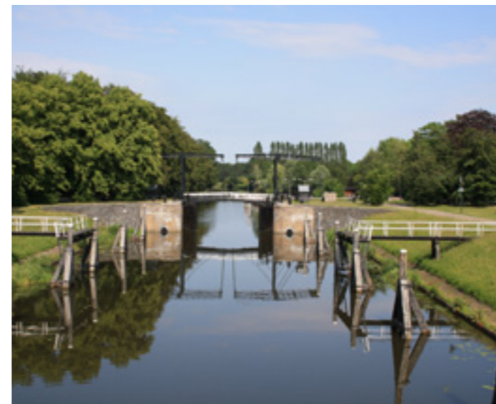
Afb. 3.26 Sluizencomplex het Katerveer in de Willemsvaart bij Zwolle.
