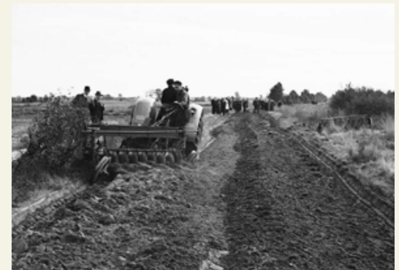
Afb. 3.48 De Heidemaatschappij is aan het werk op landgoed Junne om de grond te bewerken ter voorbereiding van de bosaanplant.
