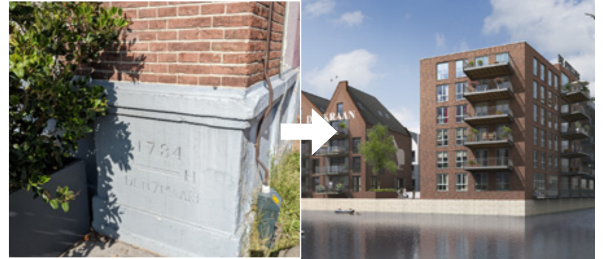
Afb. 7.5 Zorg in overstroombaar stedelijk gebied voor bouwen met meerlaagsveiligheid: hogere drempelhoogtes (zoals hier in het Kraanbolwerk), compartimentering, evacuatiegebieden.
