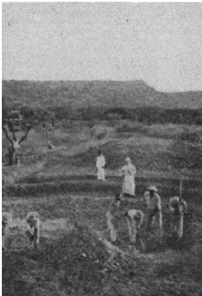
5.39 Mannen leggen Tanki Bentura aan in de omgeving van Rincon (ca. 1905). Om voorbereid te zijn op de regentijd werden tanki's en putten in de droge perioden gegraven. 68
