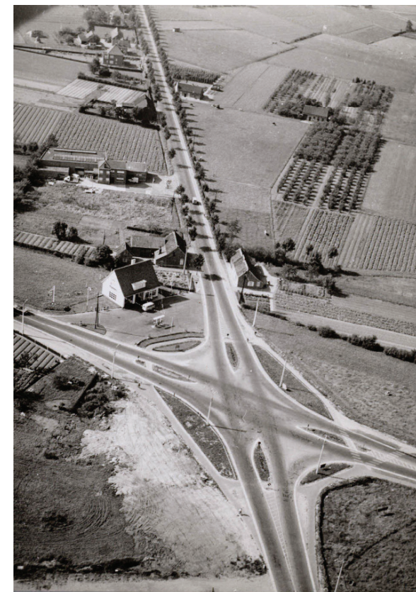
Afb. 5.32 De impact van automobiliteit: aanleg van een kruispunt in Heist-op-den-Berg (kruising provinciale wegen Mechelen-Westerlo en Lier-Aarschot).
