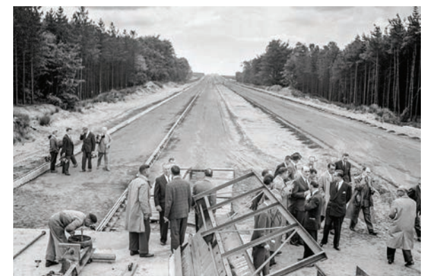
Afb. 5.33 De aanleg van de Koning Boudewijnsnelweg (1958-62).
