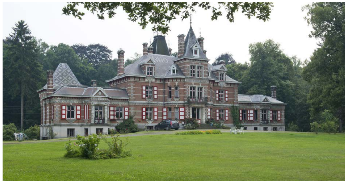
Afb. 8.36. Hof ter Laken.
