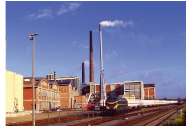
Afb. 5.35 Fosfaatverwerkende industrie bij Tessenderlo.
