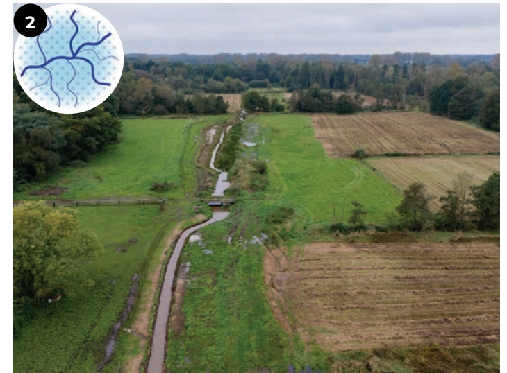
Afb. 9.17. Scherpenberg – De Hutten : Scherpenbergloop was te diep ingesneden en de natuurlijke verbinding met de vallei was verloren. Daardoor droogde de beek het gebied uit. Daarom waren de maatregelen nodig om het waterpeil te verhogen: verhogen van de beekbodem en versmallen van de beek met aanleg van een zomer/winterbed.
