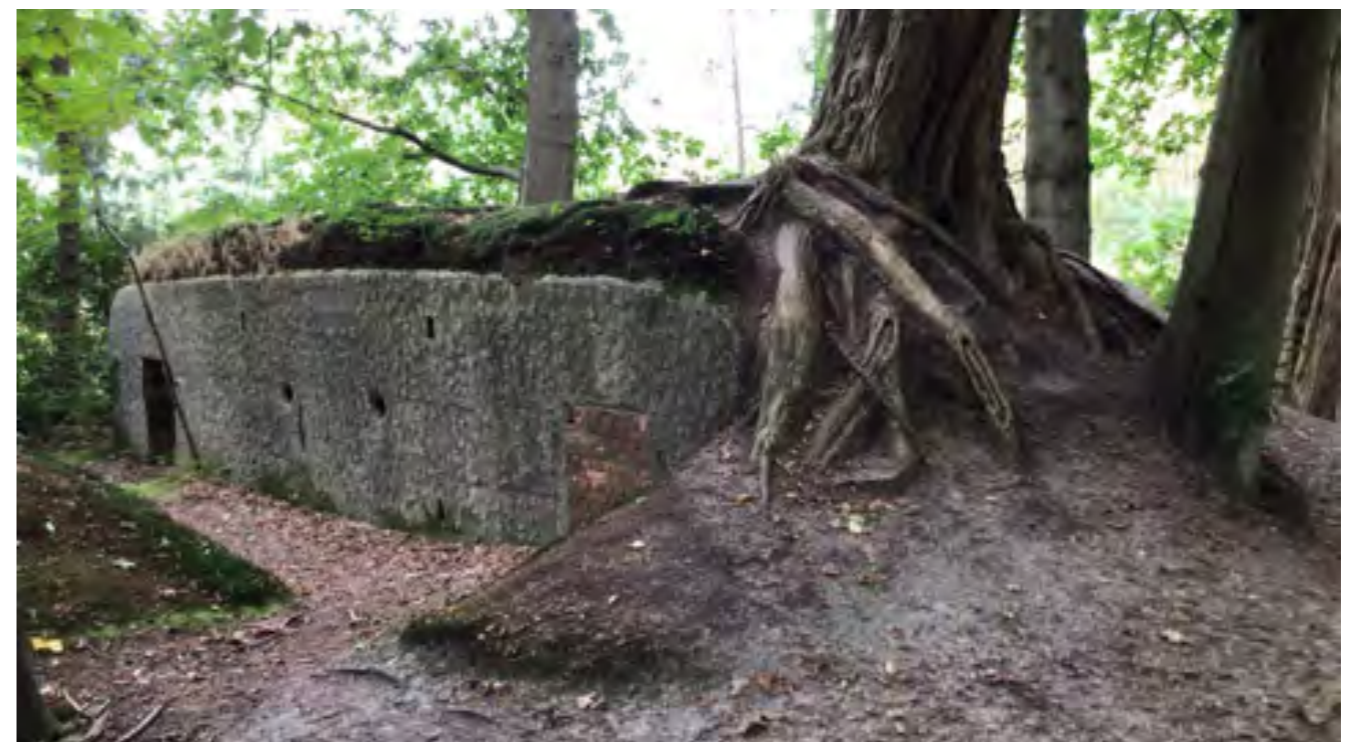
Afb. 4.50. In het Mastenbos werden de loopgraven niet gedempt. Het bos met omvangrijke loopgraafcomplex dat de vele – nog intacte – bunkers verbindt is nu een ankerplaats voor landschappelijk erfgoed. Ook op een privédomein in Schoten en het Wolfenbos in Kapellen zijn nog loopgraven te zien.
