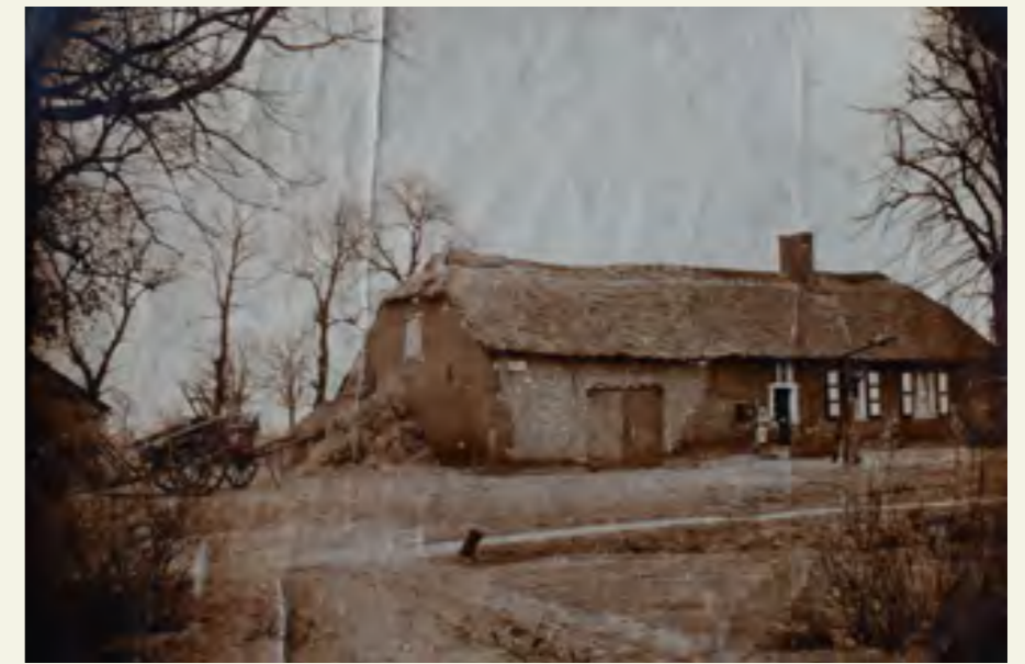
Afb. 3.14. Streuselhoop bij een langgevelhoeve in Brecht.
