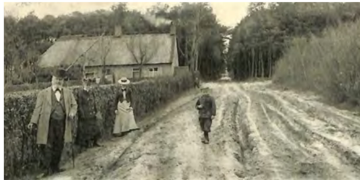
Afb. 4.2. Pas begin 19de eeuw werd in de Kempen de eerste steenweg aangelegd. Nog altijd kent het landschap veel onverharde zandwegen. Heikant, Essen.
