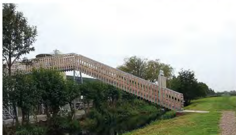
De voetgangersbrug die een directe verbinding vormt tussen een openbaar wandelpad en de koeienstal.
