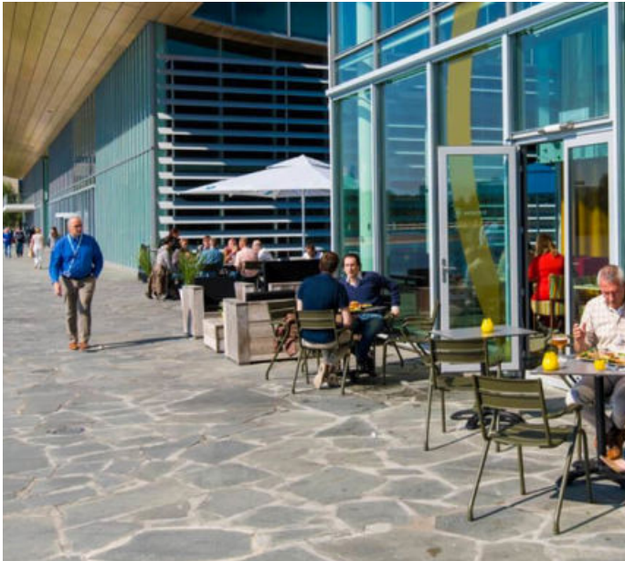
Gedeelde voorzieningen: eventspaces en horeca, Strip High Tech Campus Eindhoven
