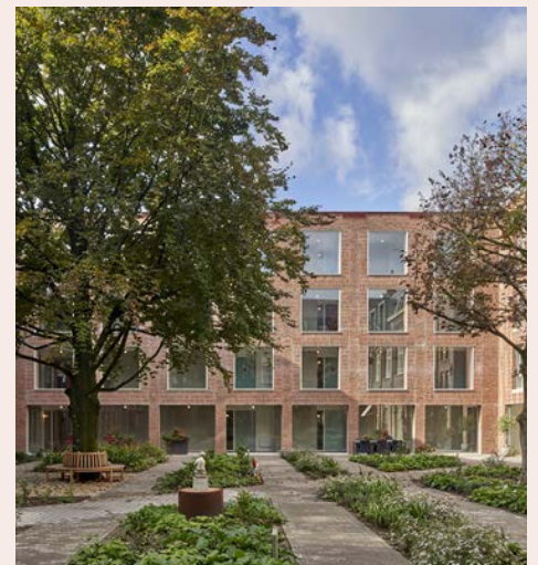
Kleinschalige transformatie binnen een cultuurhistorisch ensemble.
