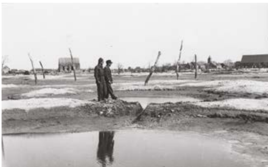
Een beeld van het overspoelde land van Walcheren, waarna het Herstelplan Walcheren is opgesteld.
