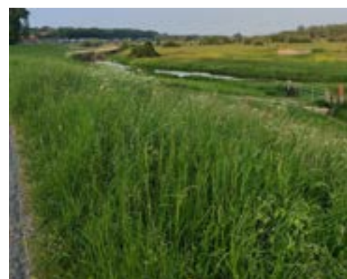
Voor de ontwikkeling van biodiversiteit moet de buitenbekleding van de dijk dikker worden gemaakt om te voldoen aan de ontwerpeisen voor bescherming tegen overstromen en tegelijkertijd een bijdrage leveren voor biodiversiteit; Wageningen, Gelderland.
