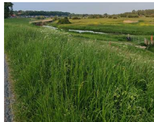
Voor de ontwikkeling van biodiversiteit moet de buitenbekleding van de dijk dikker worden gemaakt om te voldoen aan de ontwerpeisen voor bescherming tegen overstromen en tegelijkertijd een bijdrage leveren voor biodiversiteit; Wageningen, Gelderland.
