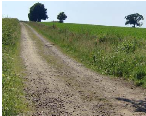
Het wegdek is van hetzelfde materiaal als het omringende landschap, waardoor het beter aansluit bij dat landschap; Deldeneresch, Hof van Twente (bron: Wikimedia Commons).
