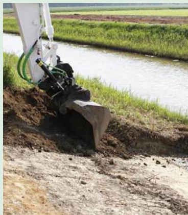
De aanleg van duurzame oevers in Flevoland. Bron: Waterschap Zuiderzeeland
