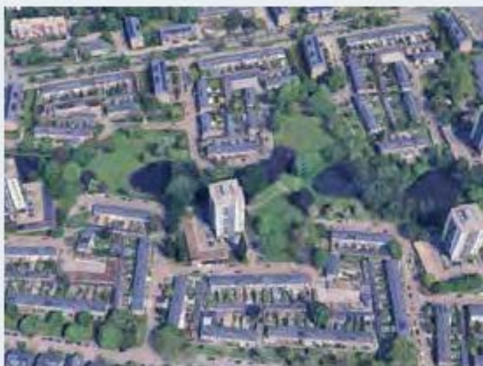
IJerschoten, Apeldoorn. Een mooi naoorlogs voorbeeld van een mix van laagbouw en hoogbouw, met ruimte voor waterberging en groen (beeld: Google Earth).
